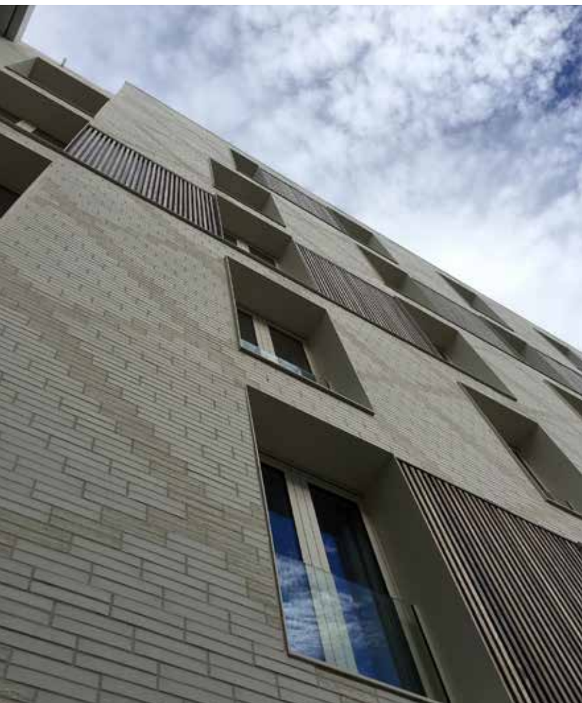
Het gebruik van twee types gevelbaksteen zorgt voor een subtiel licht- en lijnenspel.
