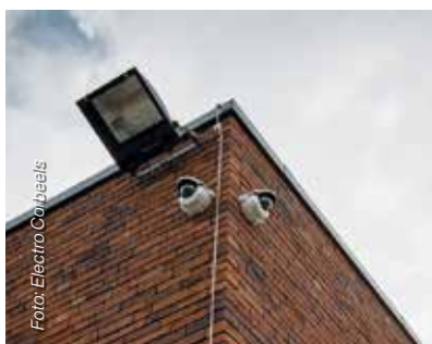
Wat camerabeveiliging betreft, stond Electro Corbeels in voor de voorbereidende bekabelingswerken.
