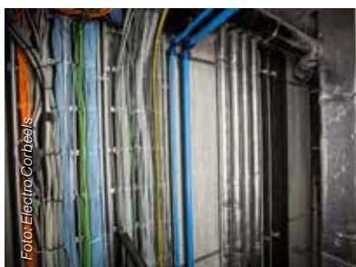
In de werkplaats werden enkele kilometers kabelgoten en (data)bekabeling aangebracht.
